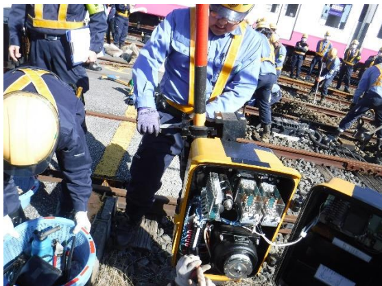
踏切遮断機復旧訓練（信号通信区）
