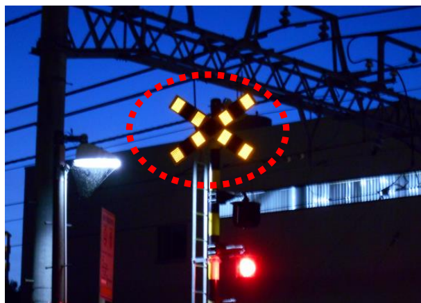
発光式踏切警標（松戸3号踏切道）
