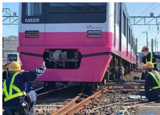
列車脱線復旧訓練（車両区）
