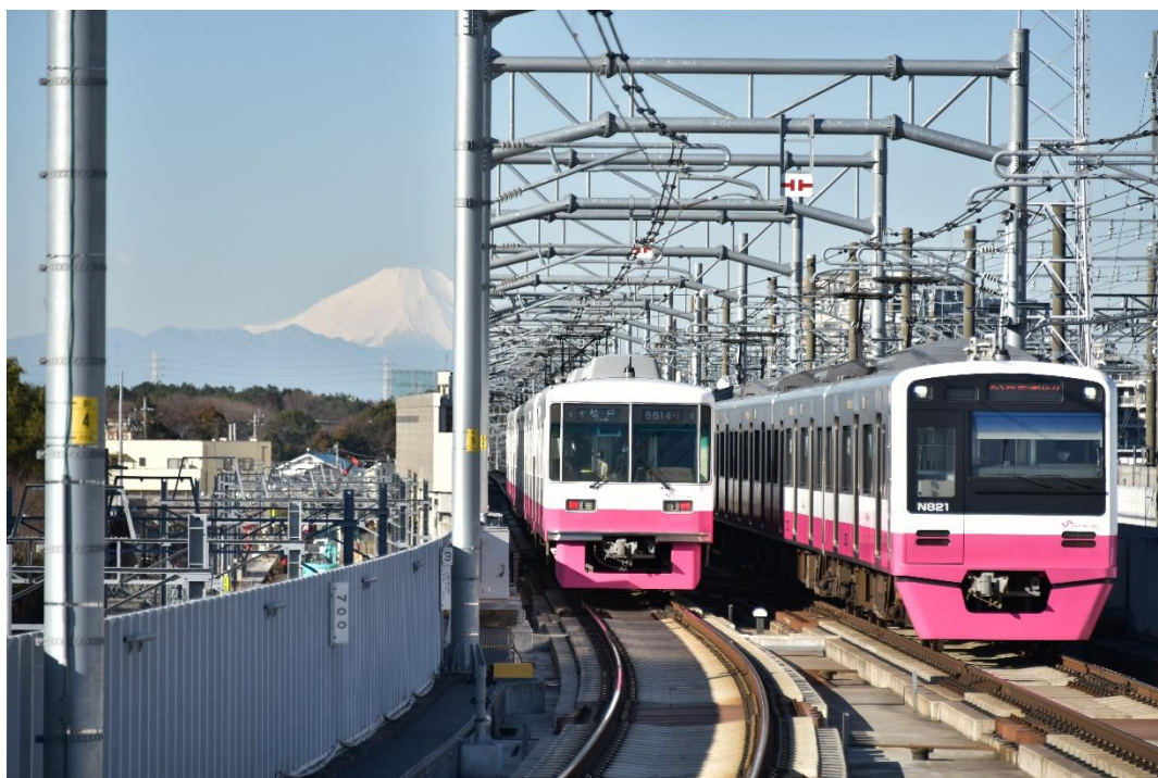
高架区間（新鎌ヶ谷～北初富駅間）の様子
