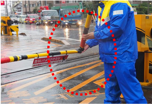
屈折遮断かん（高根公団3号踏切道）
