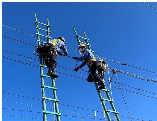
架線切断復旧訓練（電力区）
