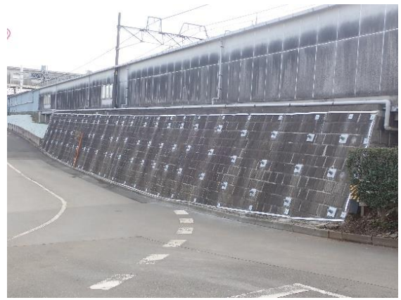
補強した土留擁壁
