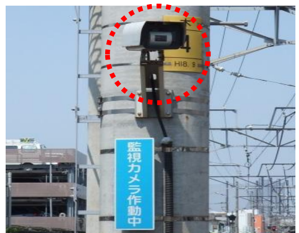
踏切監視カメラ
