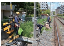
電力区による清掃活動
