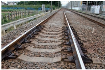
ロングレール化工事を行った線路
