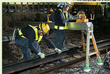
▲山越器を使ってレールの上げ下ろし
