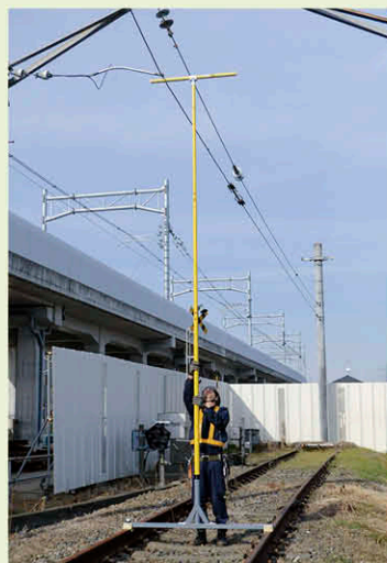
高さ測定・偏位測定
