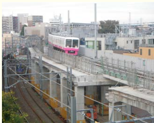
2017年10月21日 下り線高架切替工事
