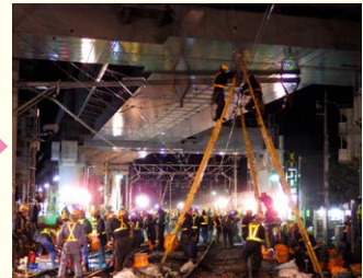
2014年2月22日 北初富地区仮上下線切替工事
