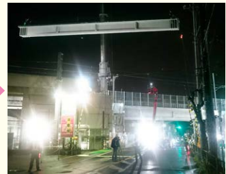
2018年11月20日 初富駅付近橋桁架設工事
