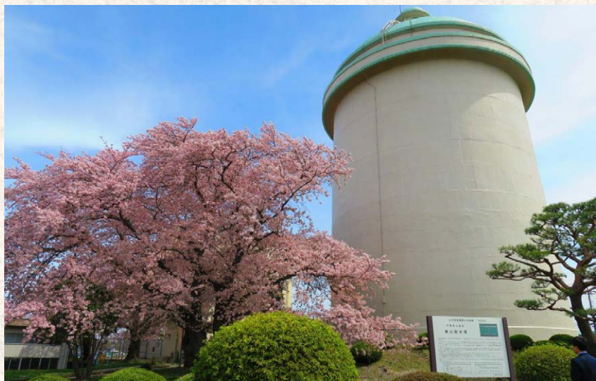
鉄筋コンクリート造、高さ31.9m、内径15m、貯水容量3,534m 3
