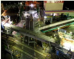
2010年9月11日 新鎌ヶ谷駅付近橋桁架設工事
