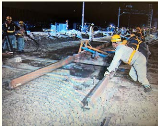
2004年2月21日 新鎌ヶ谷地区仮上下線切替工事
