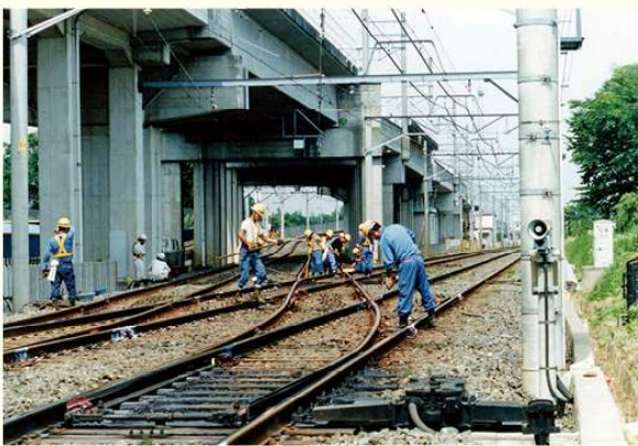
相互直通運転終了後、乗り入れ用の転てつ器を撤去している様子。
